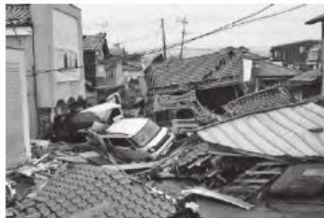
地震で倒壊した家屋や流された車両
